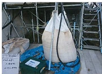
(1) 洗浄水を大型土のうに回収。
