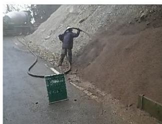
(2) チップを練り混ぜた吹付け材をのり面に吹付け。
