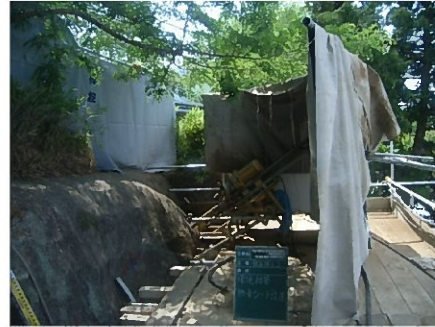
防音シート囲いの組立
