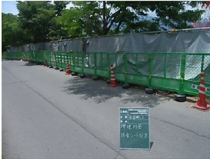
防音シート柵の架設
